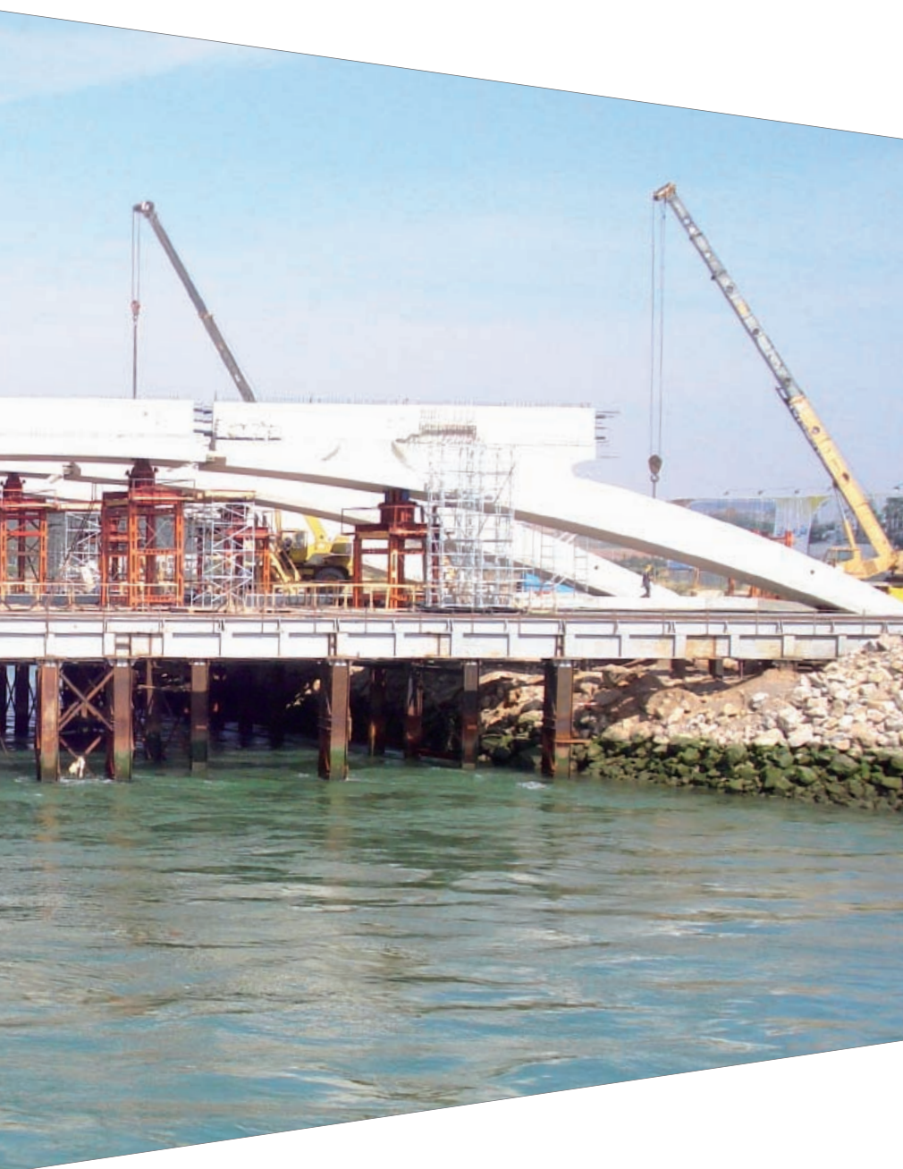
assan lors de sa construction.
