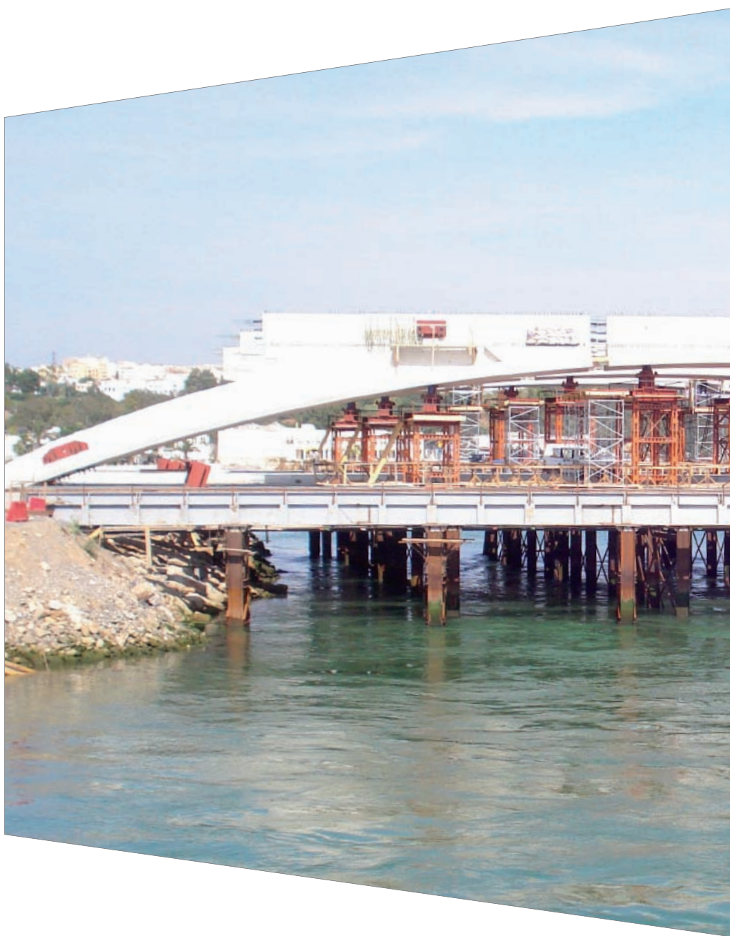
Une vue du pont Moulay El Hassan
