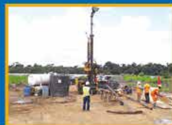
INTERVENTIONS DU LPEE BARRAGE DE NACHTIGAL AU CAMEROUN
